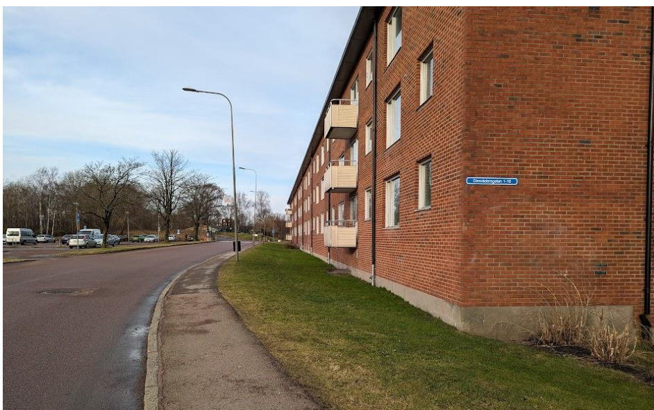
Figur 16. Mindre slänt mot befintlig byggnad i den västra delen av planområdet (Foto: Petter Mogenfelt).
