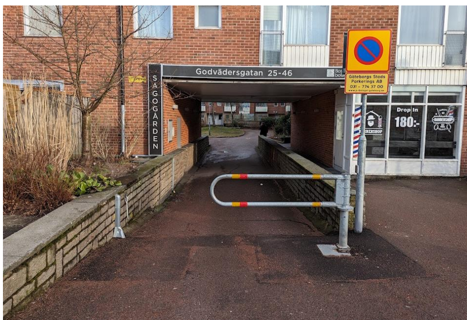
Figur 18. Nedsänkt väg under port till innergård (Foto: Petter Mogenfelt).
