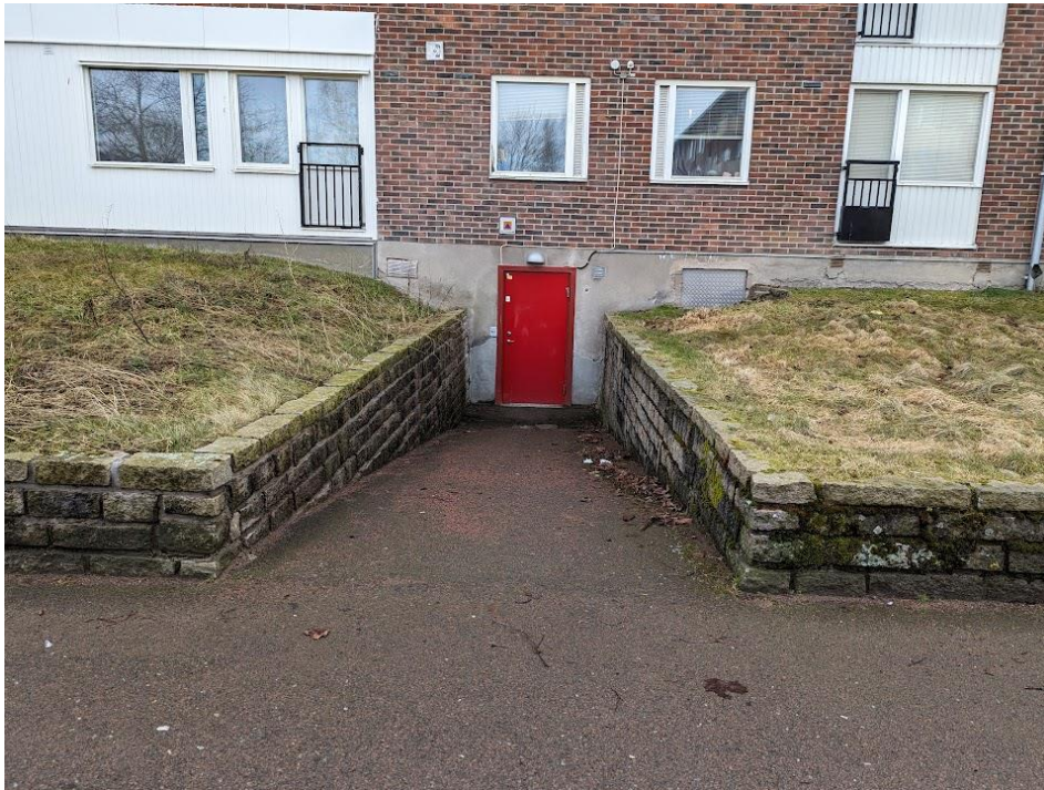
Figur 17. Ramp ner till en dörr i befintligt flerbostadshus (Foto: Petter Mogenfelt).
